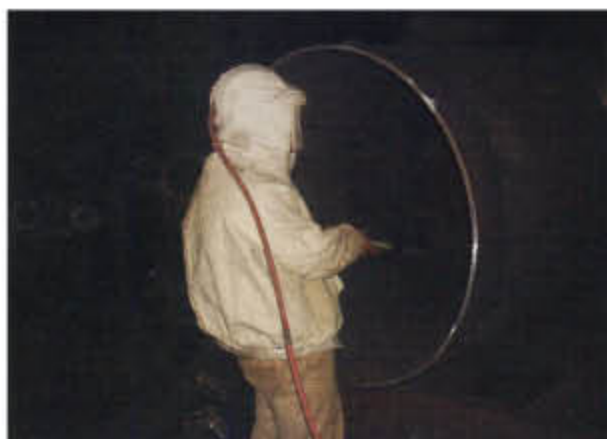
喷砂除去钢件表面的锈和氧化物，并使其达到规定的粗糙度
