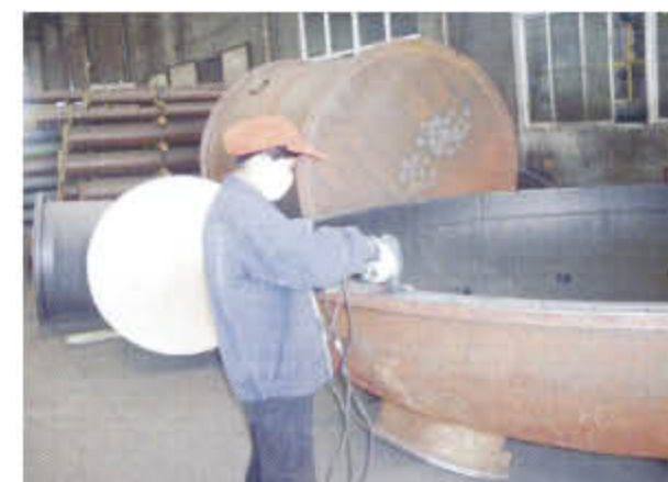
将塔边打磨平整，清理干净胶板表面
