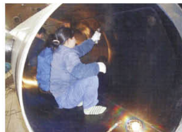
用压辊依次碾压胶板，使其紧密贴合在钢件表面，并排除胶板与钢件间的气泡
