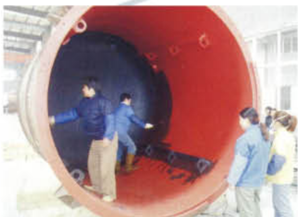
按标准的粘结体系结构依顺序涂上底涂和胶浆
